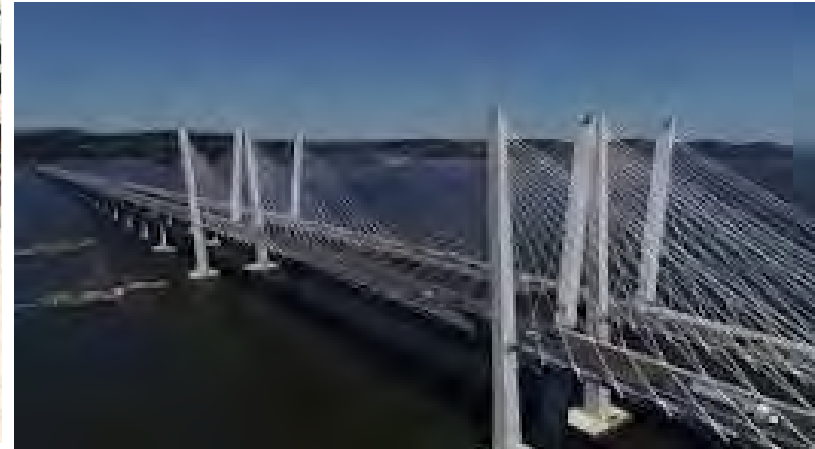
Mario M. Cuomo Bridge, NY
